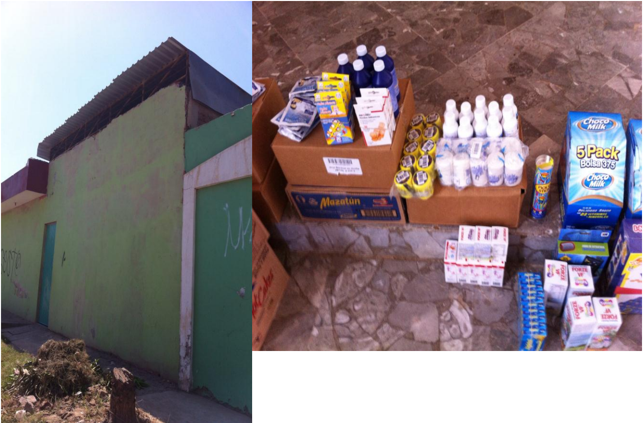
Links : die Armenküche nach erfolgreichem Umbau des Daches, rechts : Blick auf den Teil der medizin. Spenden und einen Teil der Ernährungsspende.
